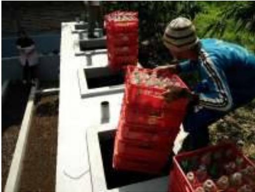
Memasukkan filter ke dalam bak anaerob
