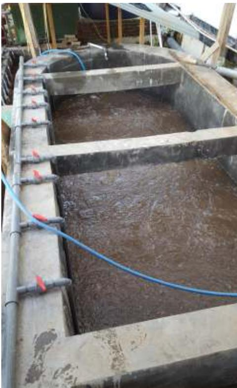
Perbaikan pipa udara di unit lumpur aktif
