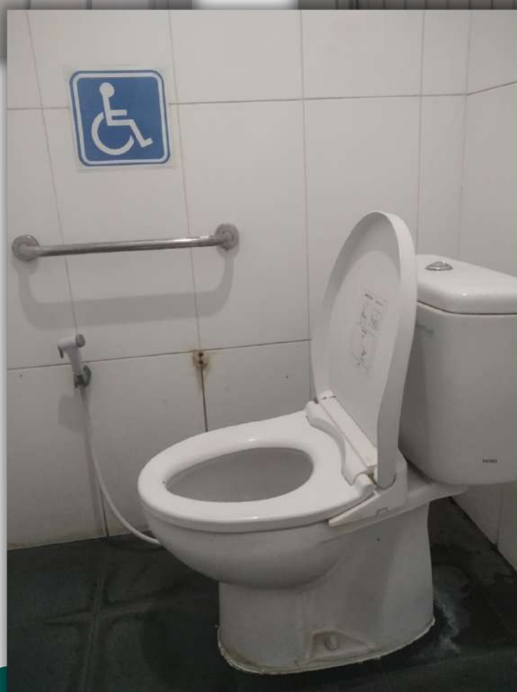
Toilet ramah difabel
