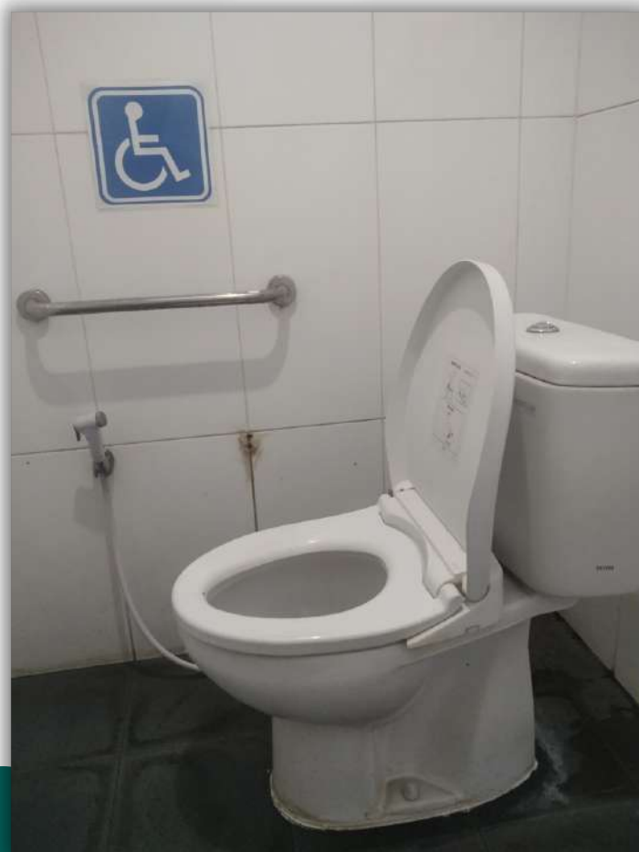
Toilet ramah difabel
